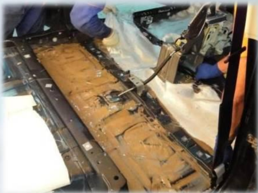
Монтаж предварительно раскроенного армирующего лицевого покрытия
