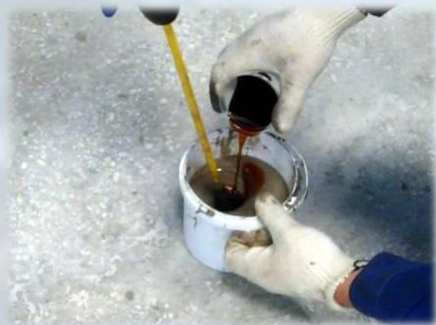
Смешивание двух компонентов упрочняющей мастики
