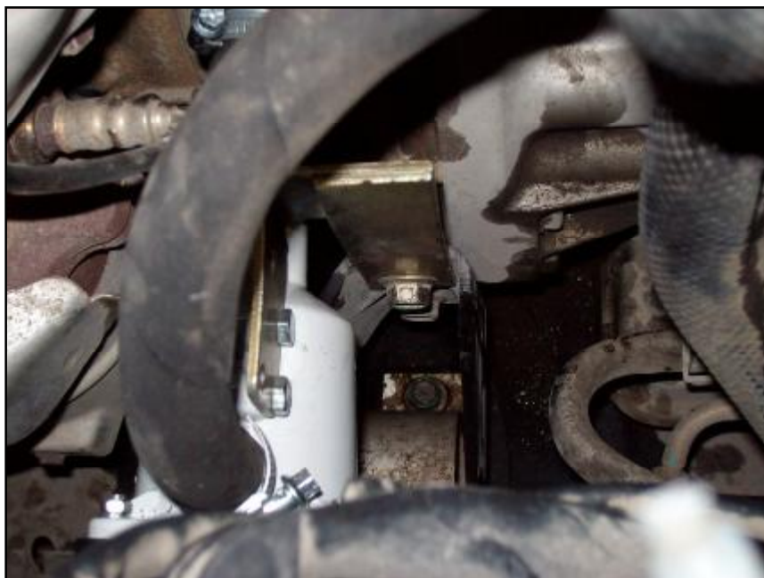
Рис.1. Монтаж кронштейна с электроподогревателем и выходного рукава.
