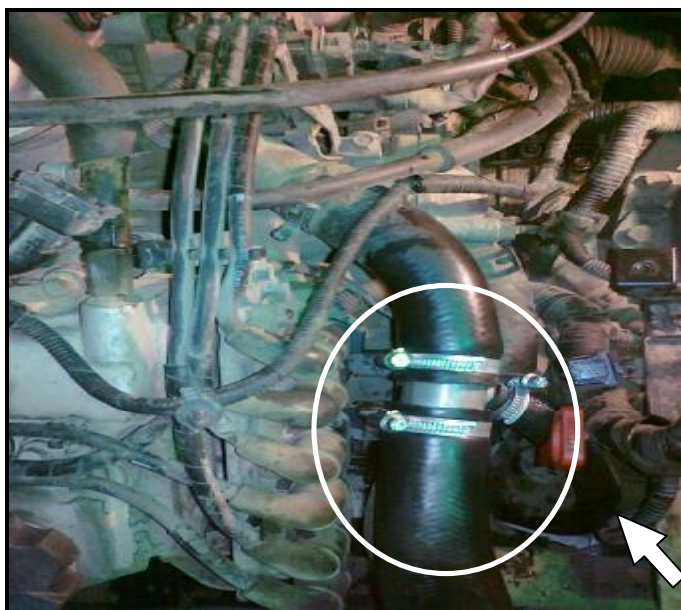
Рис.5 Монтаж тройника 35x35x16 и положение выходного рукава
